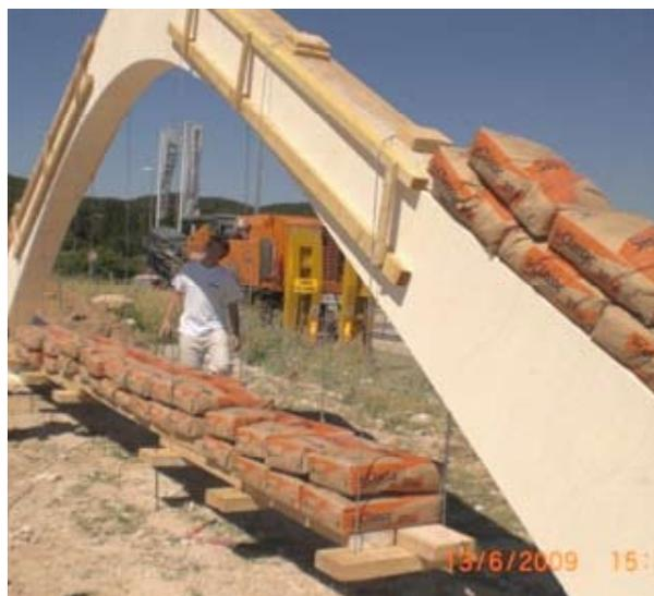
36, 37. Fasi dello stage: montaggio della centina lignea, lavorazione dei blocchi, carotaggio, montaggio, messa in trazione a 5 tonnellate, prova di carico a 4,2 tonnellate
