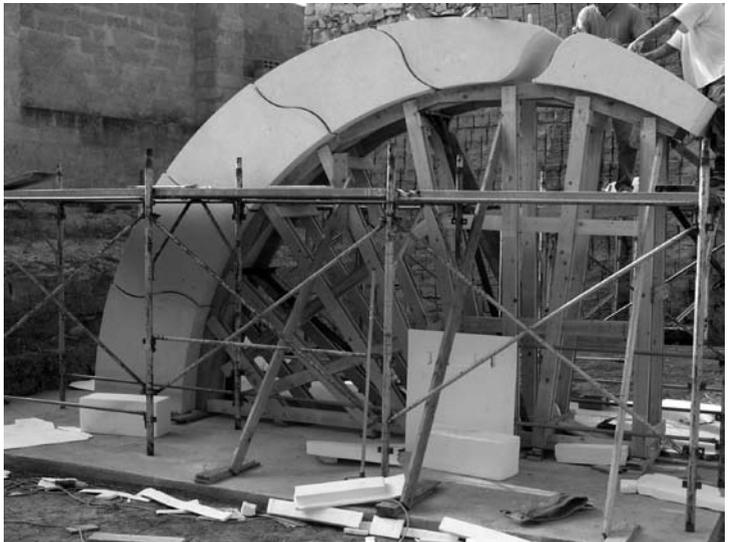
42. Lavorazione dei blocchi, predisposizione della centina, montaggio dei conci e della copertura superiore
