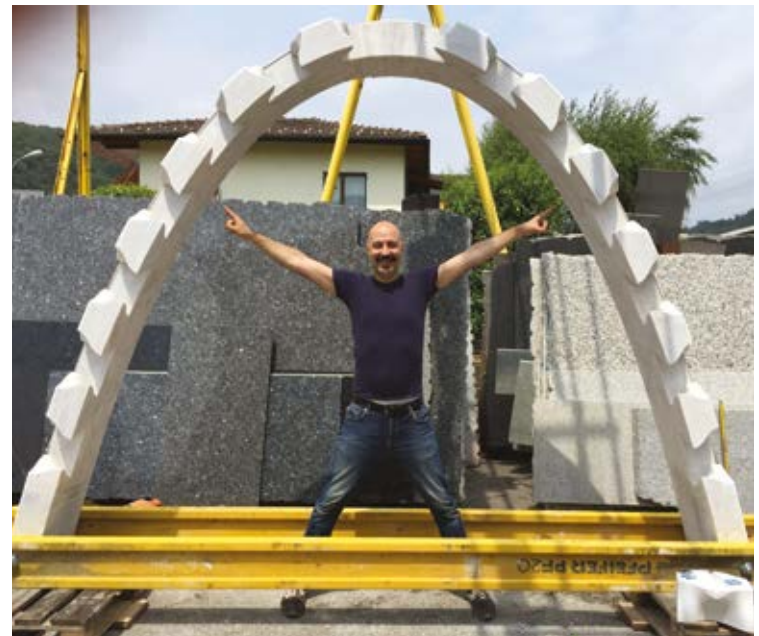
Figg. 5-6-7 Fasi di montaggio dell'arco catenario precompresso a giunti osteomorfi.
