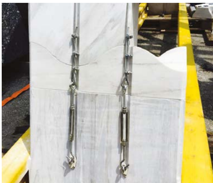
Fig. 8 Montaggio dell'arco catenario a giunti osteomorfi; Fig. 9 Armatura estradossata dell'arco per post-tensione di precompressione della struttura; Fig. 10-11 Esempificazione di montaggio.
