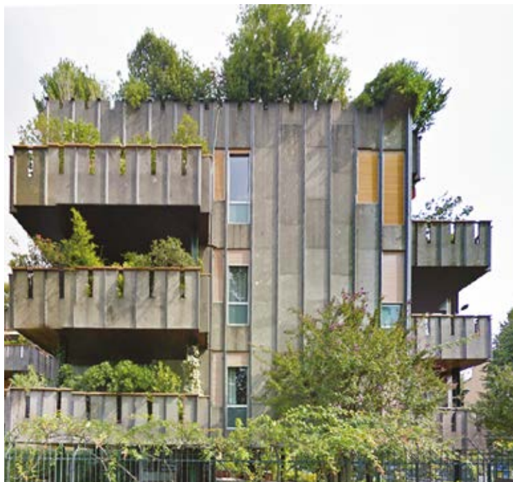
Fig. 6 Facciata dell'abitazione in via Laveno a Milano
