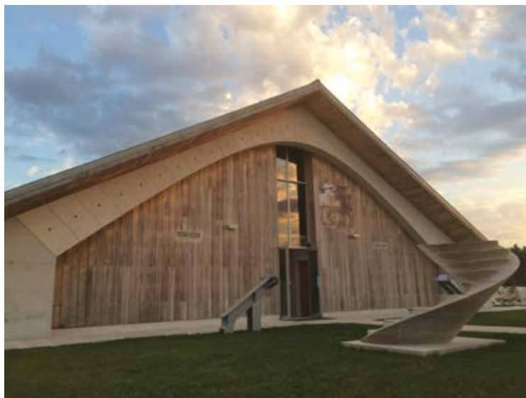
Fig. 4 Paraboloido iperbolico litico all'ingresso della sede SNBR, Troyes Fig. 4.1 Foto dell'esterno della sede SNBR Troyes con travi di imposta della "vela" di ingresso (costruzione prevista fine 2015).
